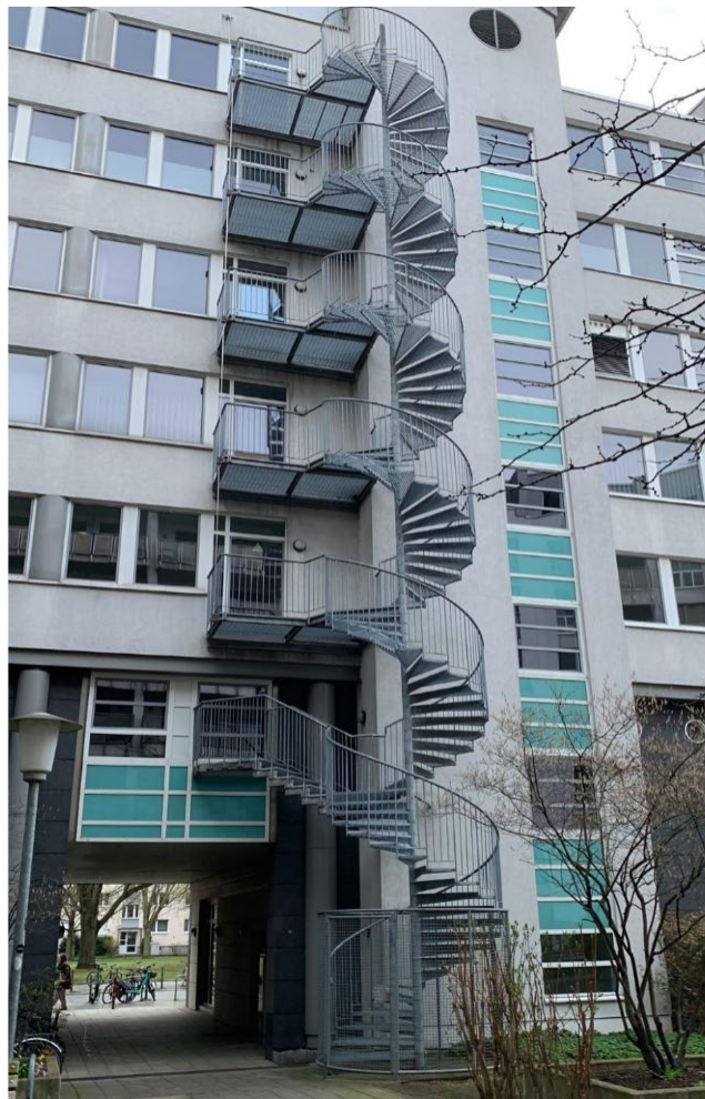
Abbildung 3.6-2: Beispielhafte Ausführung einer Spindeltreppe
