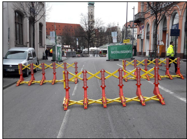
Abbildung 4: Pitagone als mobile, dynamische Sperr-einrichtung
