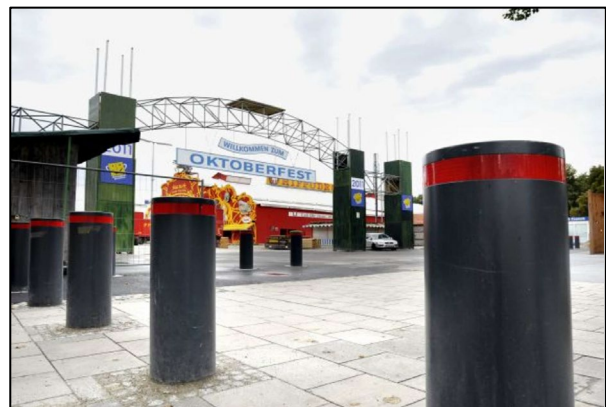
Abbildung 2: Polleranlage als festinstallierte, dynamische Sperreinrichtung
