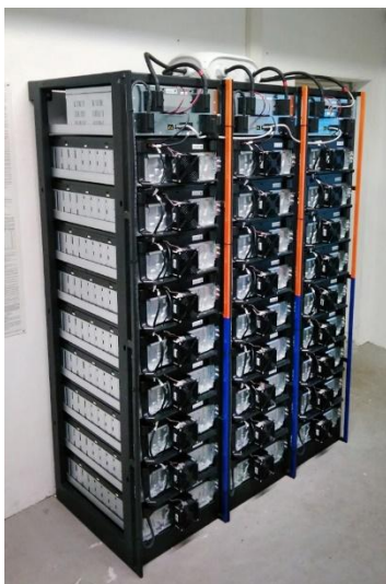
Abbildung 4: Batterieracks bzw. Batterie; Zusammenstellung von Batteriepacks oder Modulen, die eine funktionsfähige Einheit darstellen
