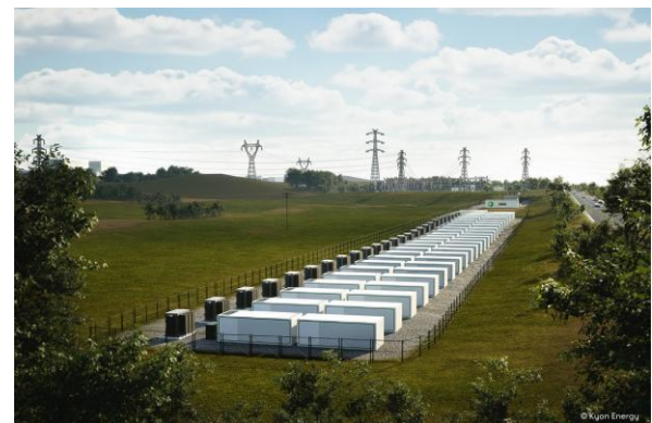
Abbildung 8: Freilächenaufstellung (GreenField) eines Lithium-Ionen-Großspeichers in Container-Bauweise
